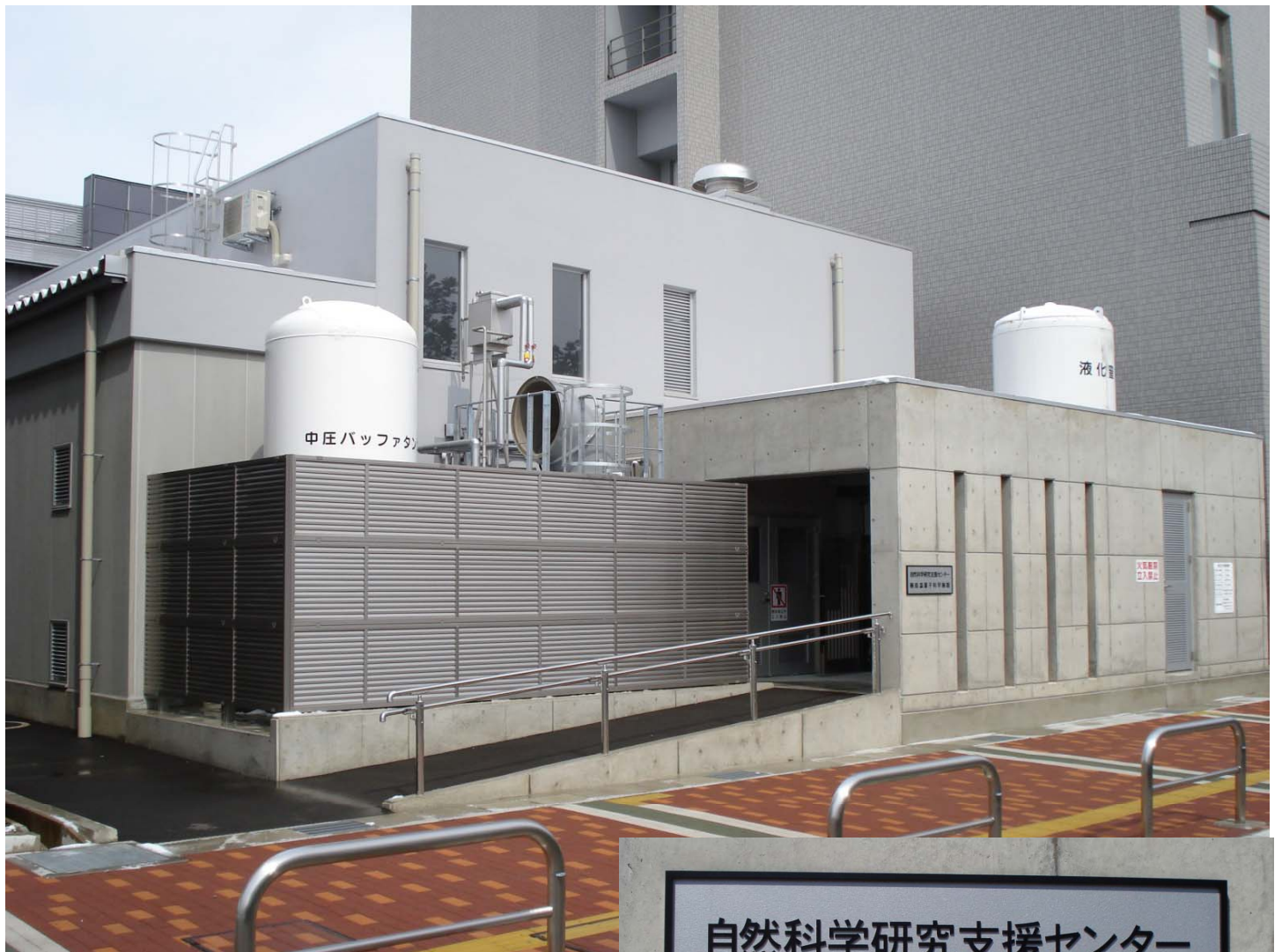
極低温量子科学施設と中圧バッファタンク、 冷却塔、液体窒素貯槽
