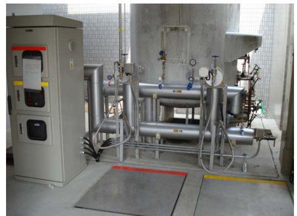
2台のロードセル(重量計)と液体窒素自動供給制御装置(左)
