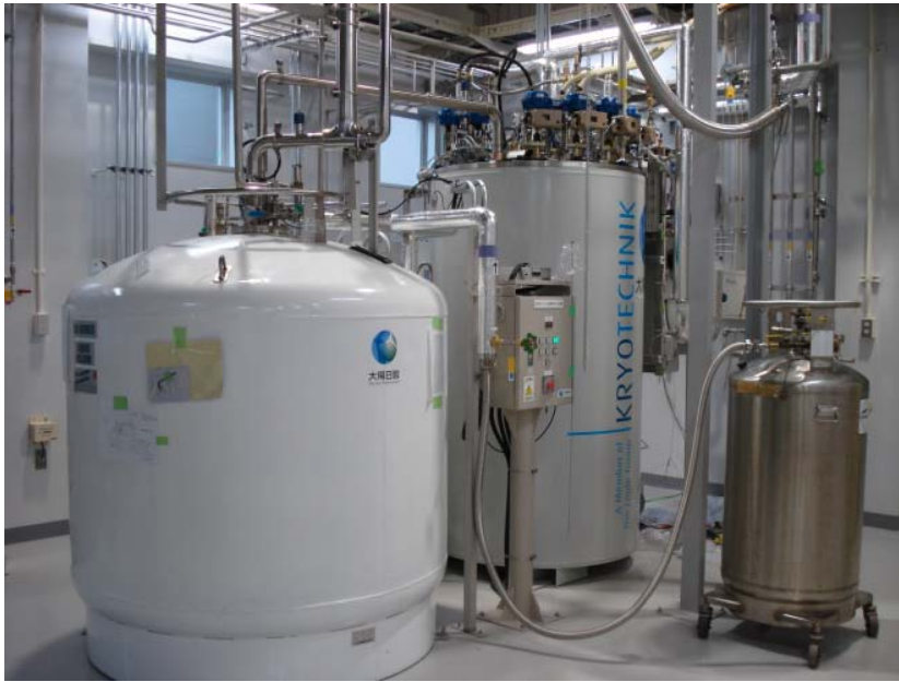
ヘリウム液化機(中央)、液体ヘリウム貯槽(左)、液体ヘリウム容器(右)
